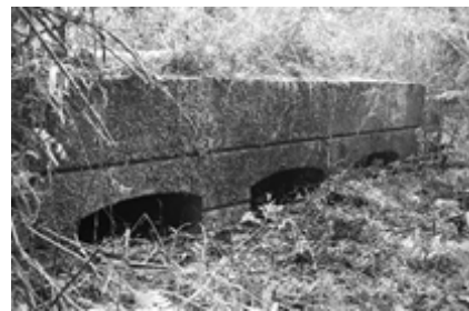
写真 建物基礎下部
