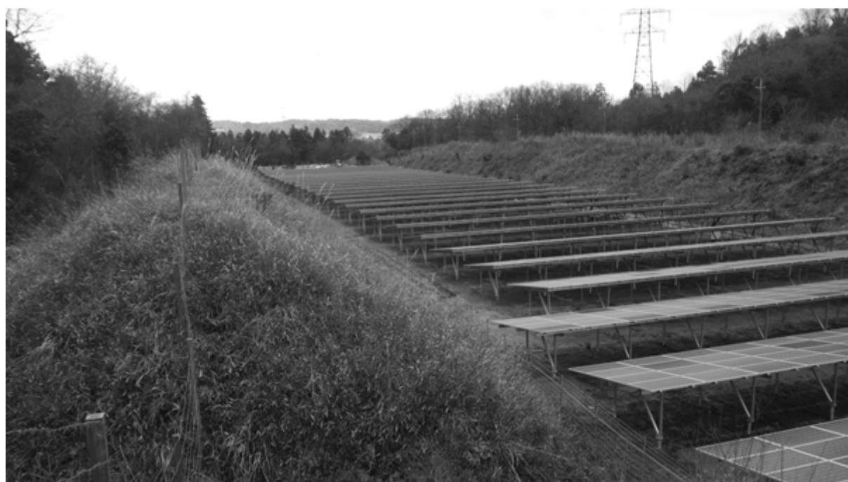
射撃場全景（北東から）。太陽光パネルの両側は防弾土塁。
