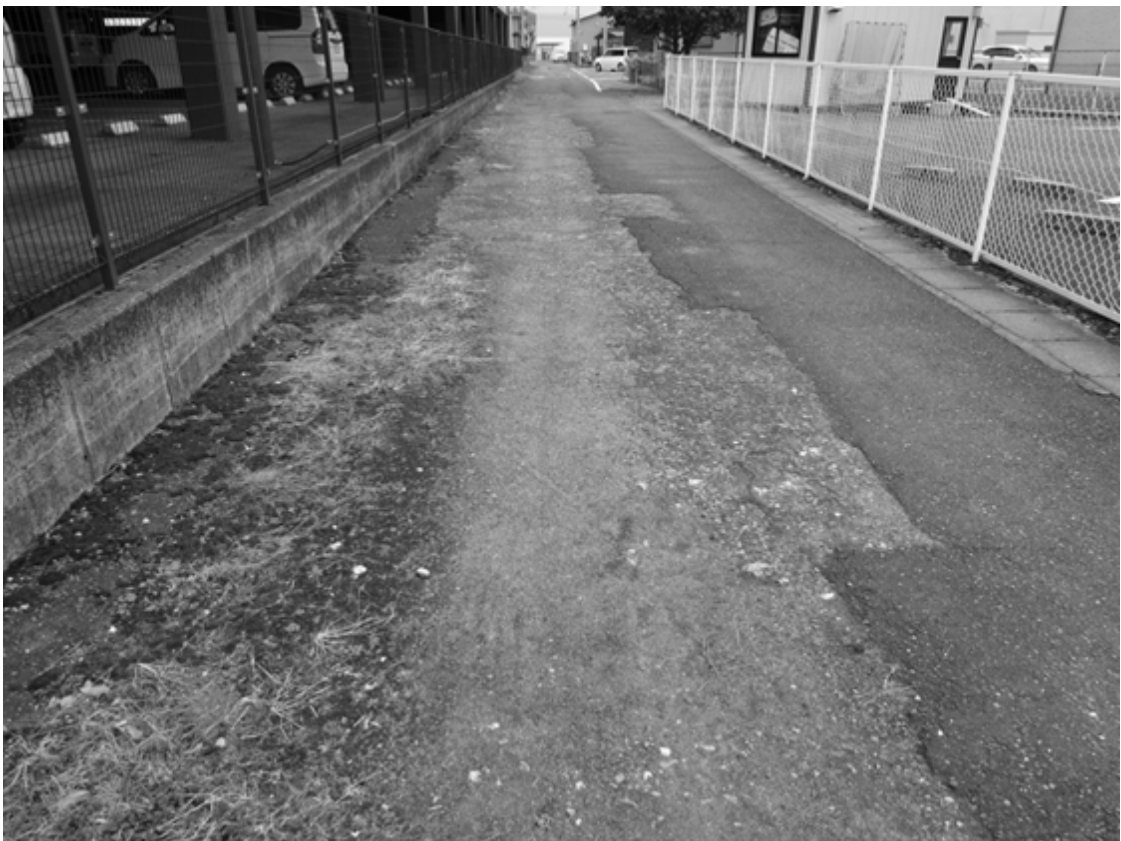
戦闘準備線の舗装（北より 写真の路地中央のコンクリート舗装が当時のもの）
