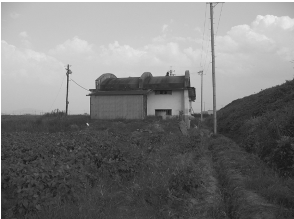
野田沼干拓地のポンプ小屋（現在は廃止）
