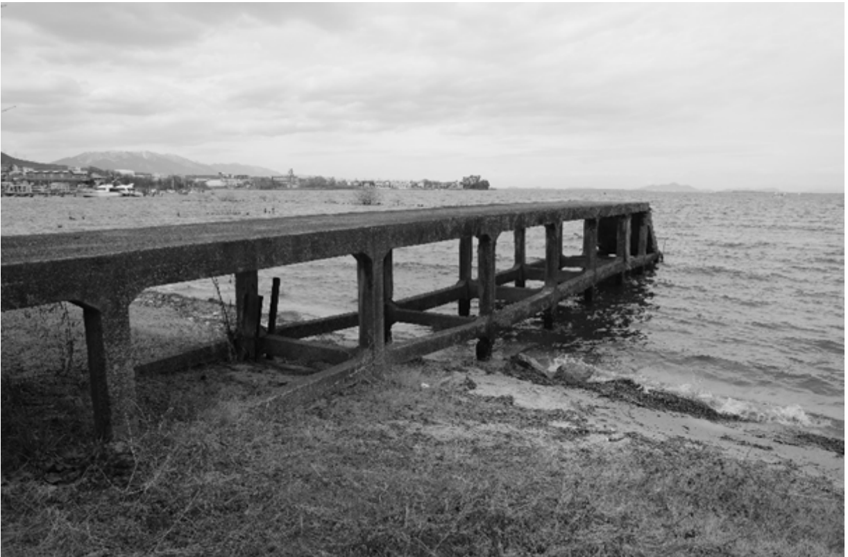
写真5 コンクリート製棧橋
