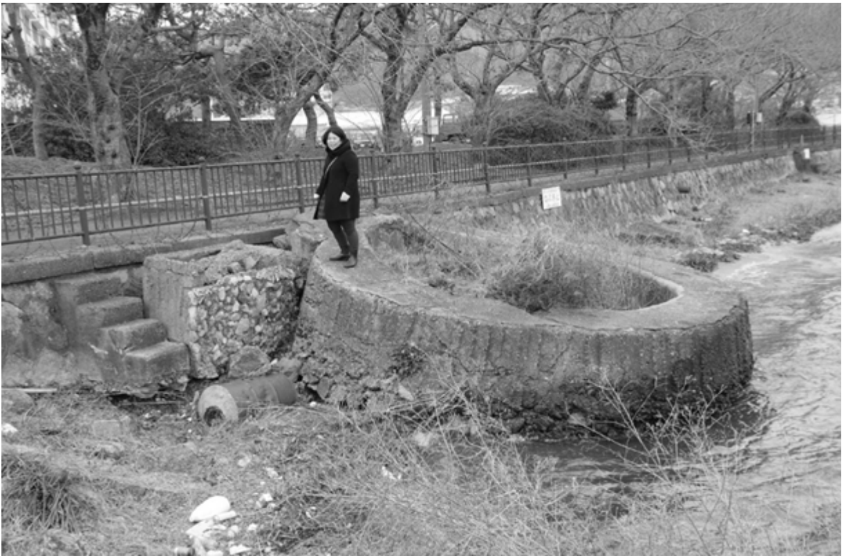
写真6 用途不明コンクリート基礎
