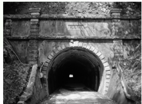
東側出入口の現況
