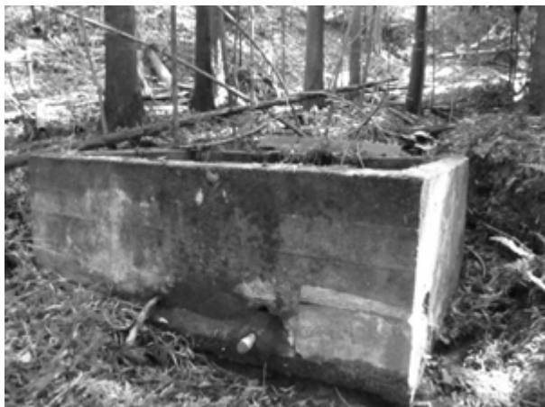
コンクリート桁の現況
