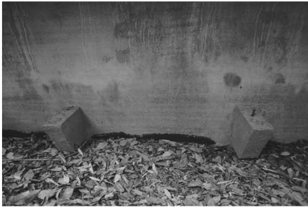
写真5 壁面突出部の詳細
