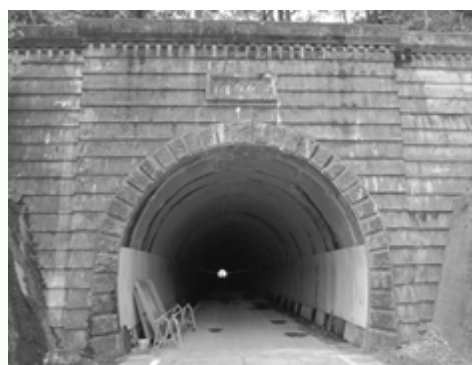
東側出入口の現況
