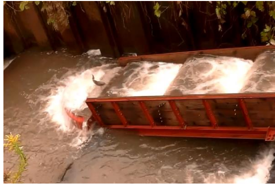
図7 落差工の魚道を遡上するビワマス
