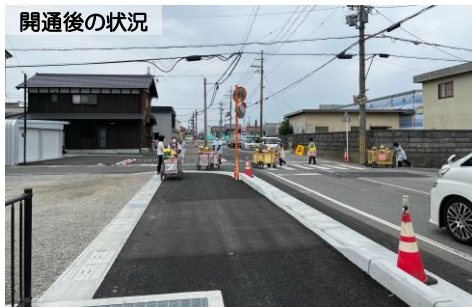
開通後の状況
