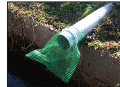
ネットを設置した排水パイプ
