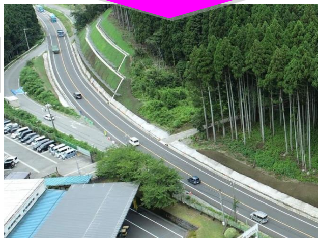
開通後 の状況
