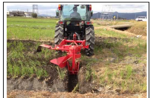
オーガ式溝掘機等で しっかりした排水溝を作る
