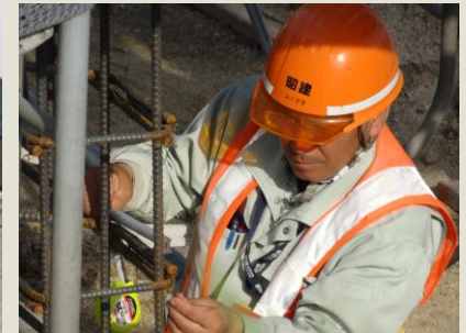
工事現場技術者による施工管理
