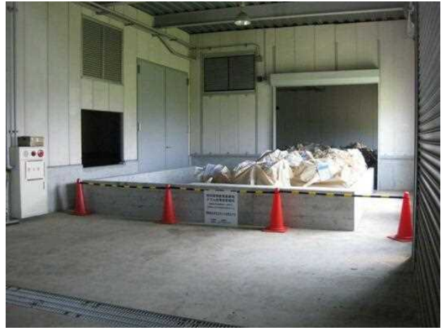
室内仮置廃棄物保管対策工 対策後
