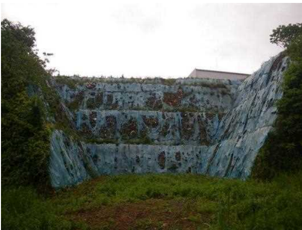
仮設シート（西市道側法面部） はり替え前
