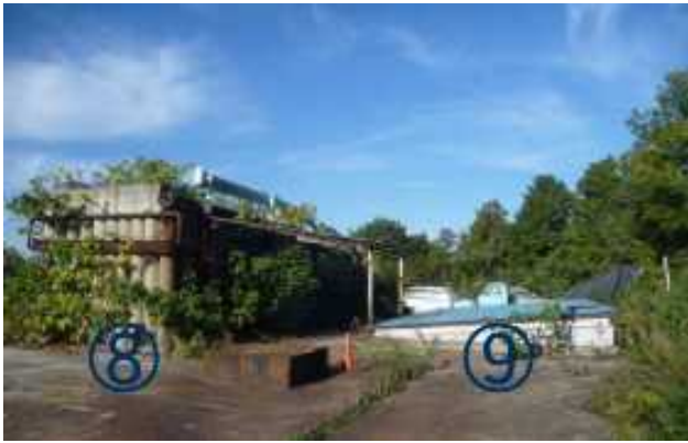
⑧～⑨ 焼却炉スロープ 等
