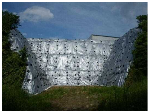
仮設シート（西市道側法面部） はり替え後
