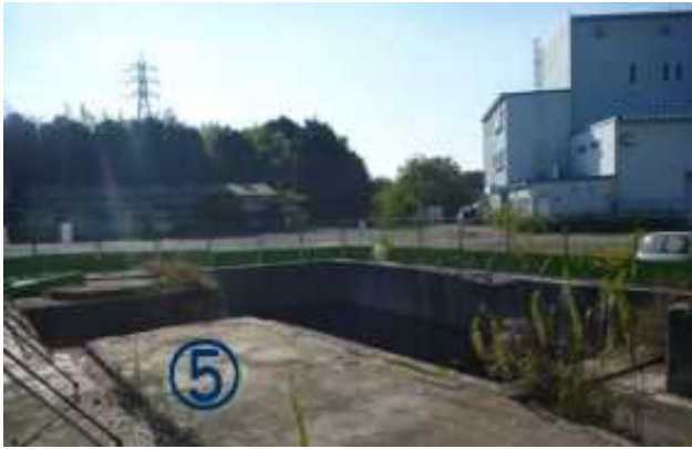
⑤南側焼却炉基礎
