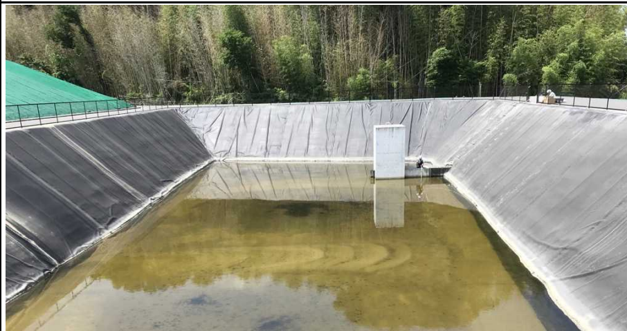
写真① 調整池付近の様子
