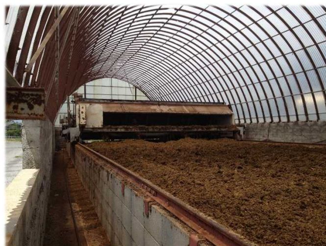
発酵堆肥化施設
