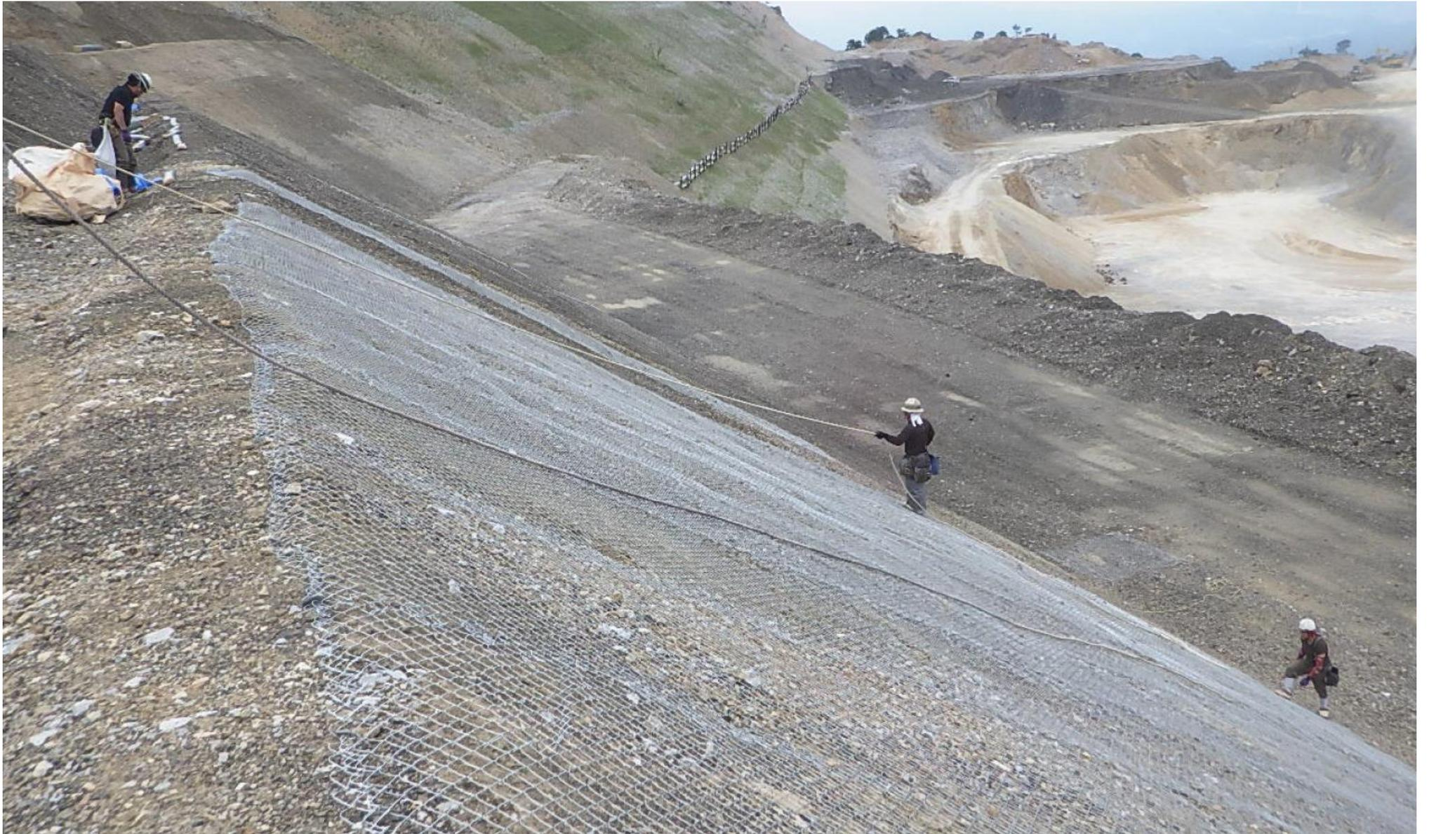
造成した斜面にラス網を張ります。 網目ひし形 一辺 50 mm
