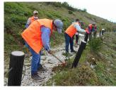
西登山道保護杭補修および防護ロープ引き換え4日目の作業は、7名の会員で2班に分かれ実施。一班2名は西登山道入口より鉄杭場所150mの間のロープ張り作業、もう一班5名は前回実施の場所より下方100mの擬木の補修作業を実施しました。報告はWANちゃんでした。
