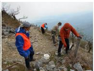
5名の会員で西登山道保護杭補修および 防護ロープ引き換え作業を行いました。西 登山道折り返し付近からスタートし、倒れ た支柱は抜いて新しく打ち替え、傾いた支 柱を補修しました。登山道脇は石灰岩が多 く作業は困難を要しました。また、古くな ったロープを新しいロープに引き換えまし た。報告はWAN ちゃんでした。
