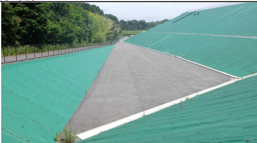
写真① 西市道側の様子
