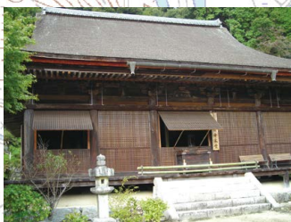
重要文化財桑実寺本堂
