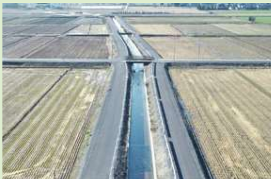
水路（排水路）の更新工事 （長浜市益田町・安養寺町・富田町）
