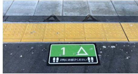
内方線付き点状ブロックの整備
