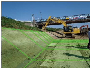
ICT建設機械を用いた施工
