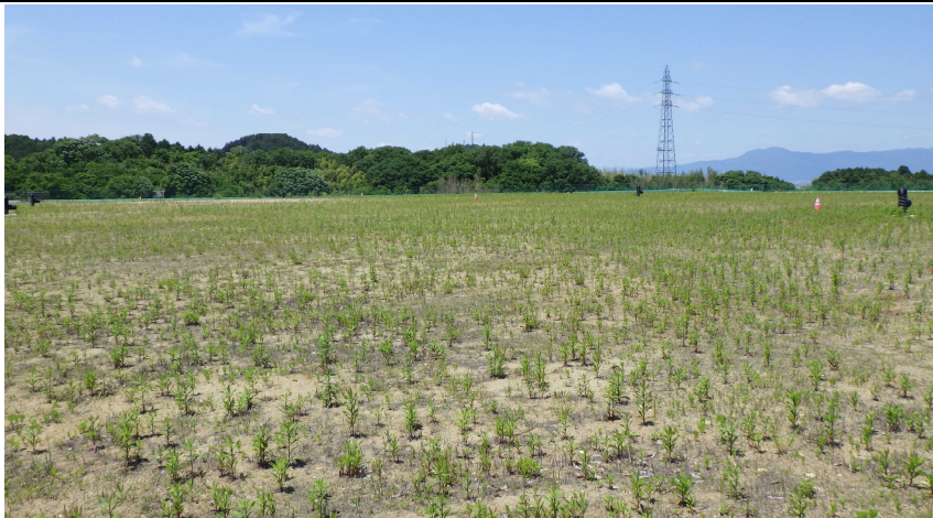
写真② 天端部の様子
