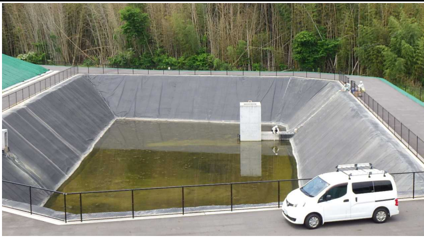
写真① 調整池付近の様子
