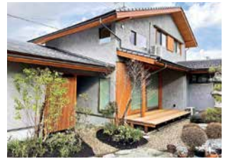
▲びわ湖材を使用した住宅
