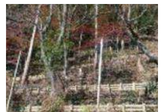
▲土壌流出防止施設事例
