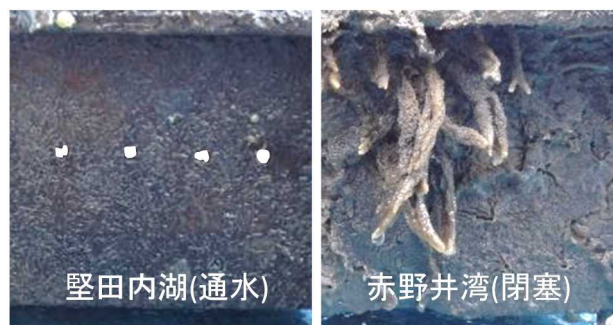
図2 通水穴の状況
