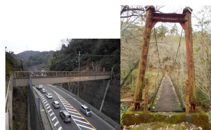
東海自然歩道 歩道橋
