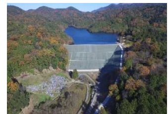
ため池の耐震化工事
