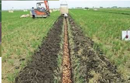
暗渠排水の整備
