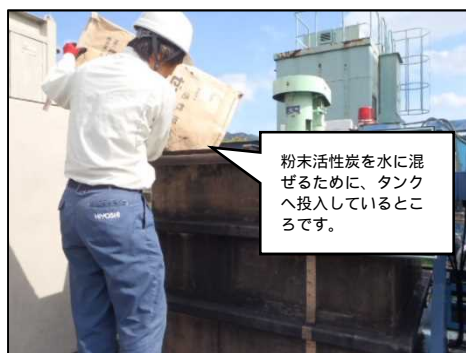
粉末活性炭の投入状況
