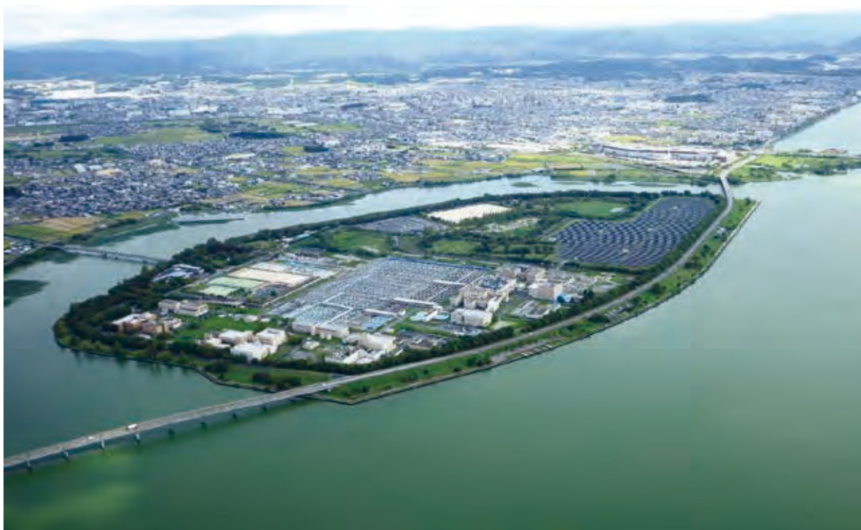
▲湖南中部浄化センター（草津市）
