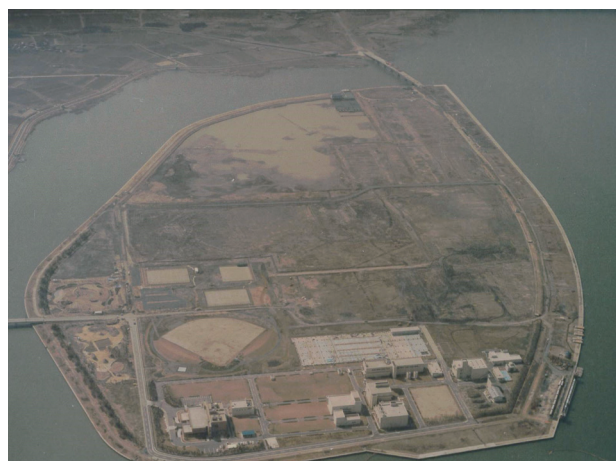
湖南中部浄化センター
