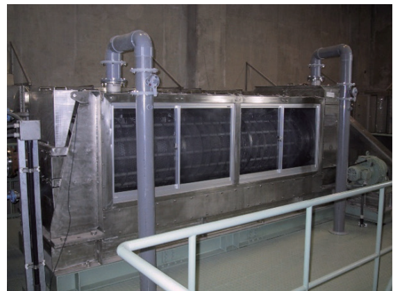
スクリュープレス式脱水機
