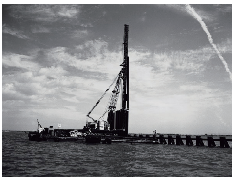
湖南中部浄化センター護岸工事
