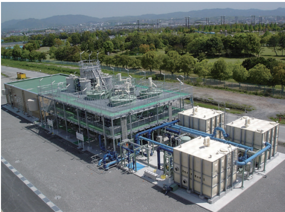
超高度処理実証施設
