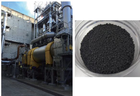
湖西浄化センター燃料化施設と燃料化物
