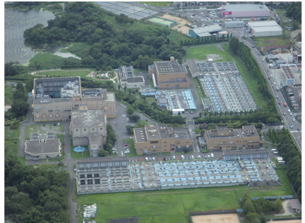
湖西浄化センター
