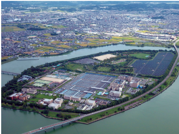
湖南中部浄化センター
