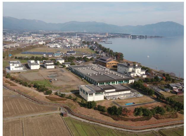
高島浄化センター
