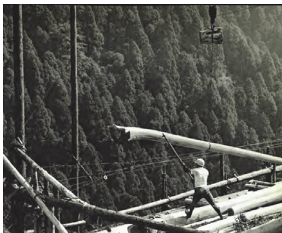
▲架線集材作業（彦根市犬上郡営林組合 1969 年撮影）
