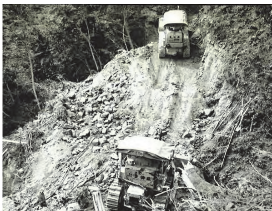
▲林道先端でのブルドーザーによる開設作業（彦根市犬上郡営林組合 1969 年撮影）
