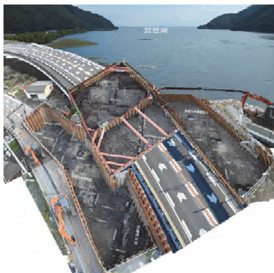
▲地下 4m から見つかった 12 世紀の塩津港遺跡
