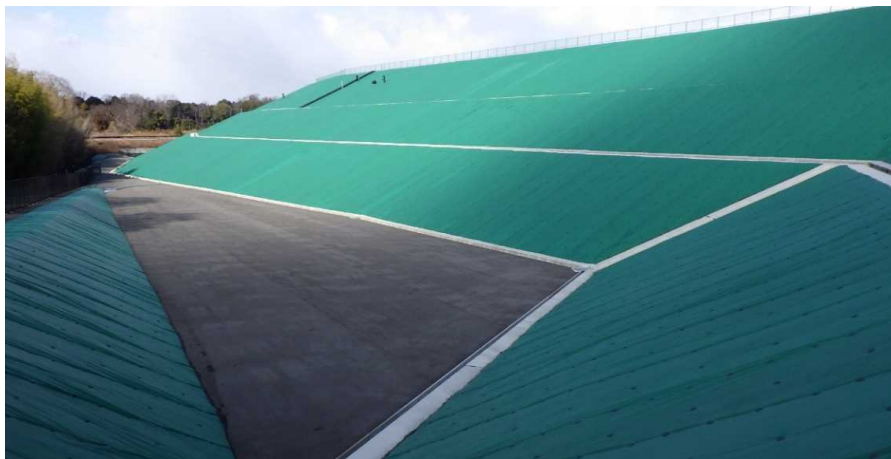
写真① 西市道側の様子
