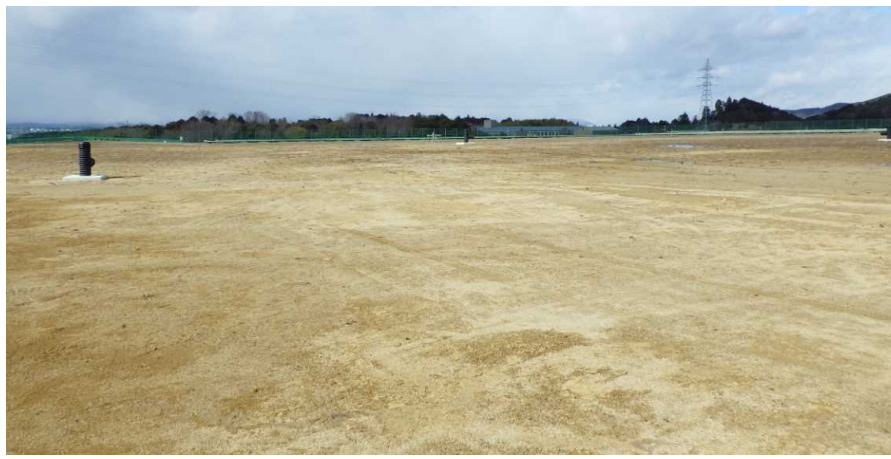
写真② 天端部の様子
