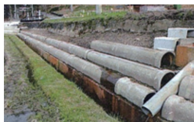
法面U字溝再利用防草工事
