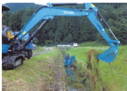
水路土砂上げ
