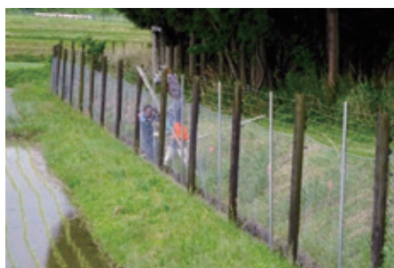
獣害柵補強工事
