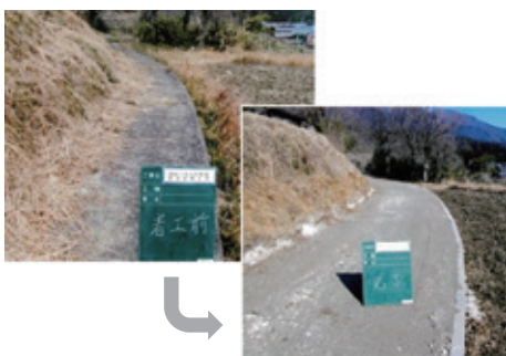
道路拡幅工事（着工前・着工後）
