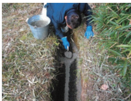
用水路の補修
