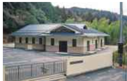
农业村落排水处理设施
