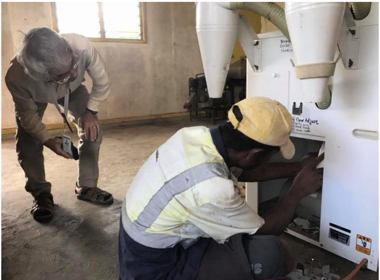
④精米機修理
