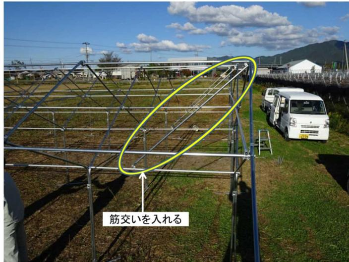
図 34 筋交いによる妻面の補強
