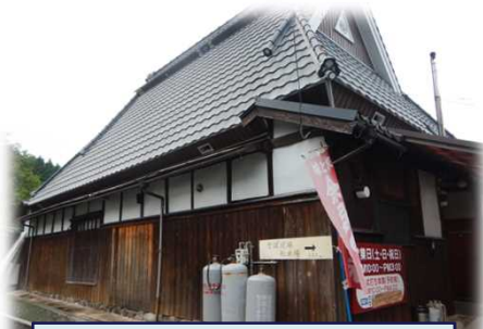
古民家を改修してそば道場に
