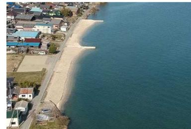
横江浜砂浜保全（突堤工、養浜工）
