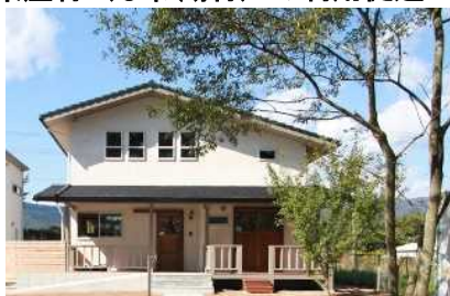
びわ湖材を使用した住宅
