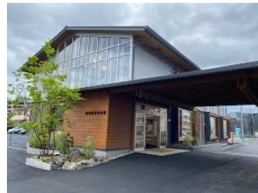
滋賀県林業会館
