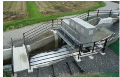
農業用水路の落差を利用した小水力発電 （米原市姉川沿岸土地改良区）
