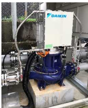
管水路用マイクロ水力発電システム (近江八幡市長福寺町)
