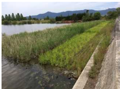
木浜内湖底質改善対策（覆土工） （守山市木浜町他）
