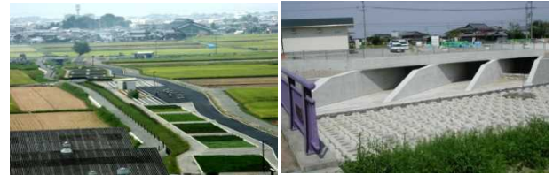
山寺川市街地排水浄化施設「伯母川ビオ・パーク」
