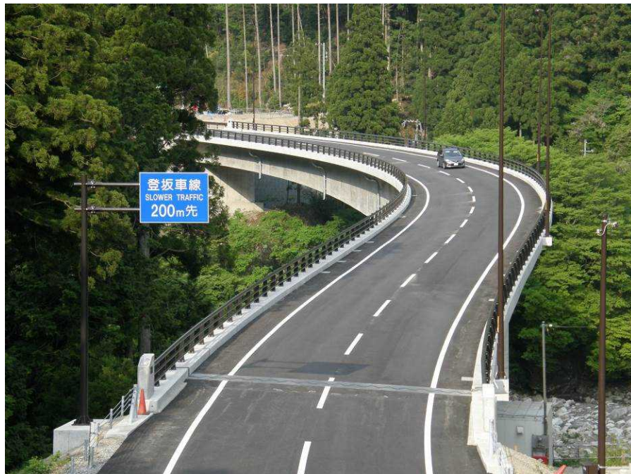
地中熱を利用した融雪装置を有する橋梁 (国道 421 号不老橋)
