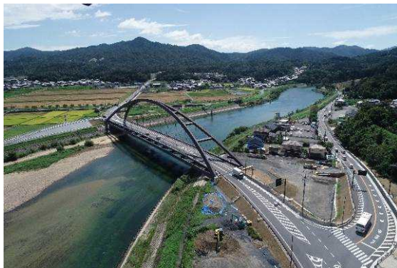
国道422号 大石東バイパス (瀬田川令和大橋)
