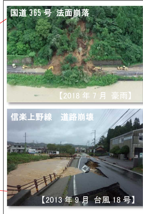
27 台風等による被害状況
