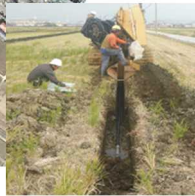
暗渠排水の整備
