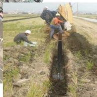
暗渠排水の整備
