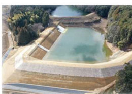
ため池の耐震化工事
