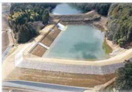
ため池の耐震化工事
