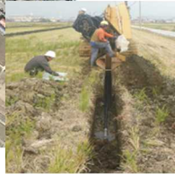
暗渠排水の整備
