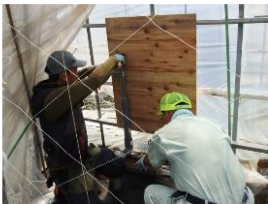
ICTバルブの設置指導
