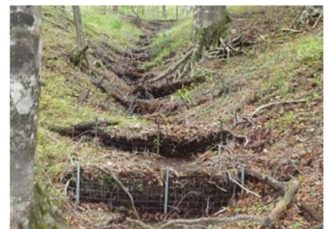
イノシシ用防護柵の金属部品を使用した例
