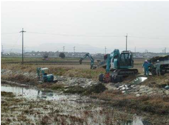
中型重機1台と小型重機2台で作業 中型重機はワイヤ- (50m) 付き
