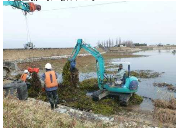
小型重機により揚陸する
