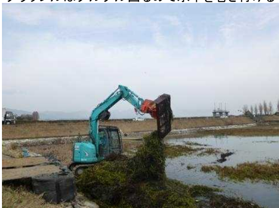
特製の鋼製ザルでちぎれた水草をすくい取る
