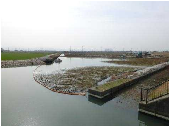
汚濁防止膜により、ちぎれた水草の流出を防止
