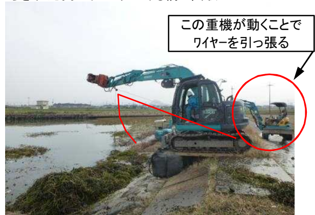
長距離(50m以上)になると中型重機を支点にして、 小型重機で引っ張りよせる
