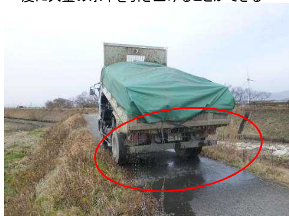
ダンプに積み込み後、荷台を傾斜させて水を切ってから運搬する
